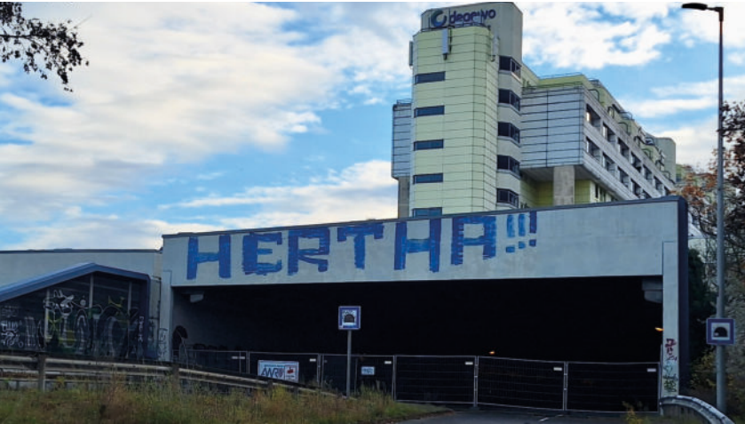
Der gesperrte Schlangenbader Tunnel Foto: Jürgen Jänen
